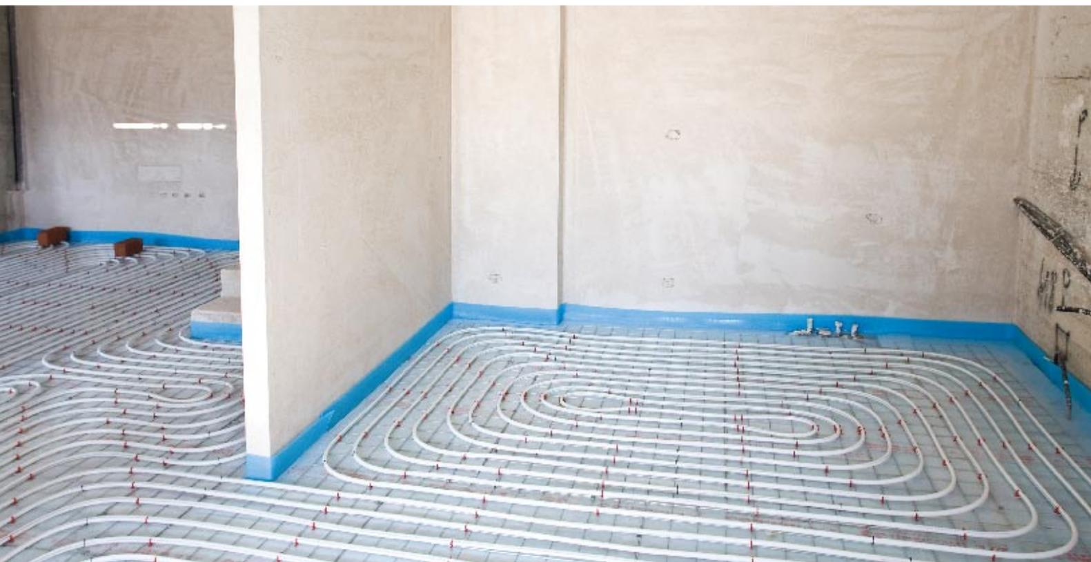
Ciascuna abitazione, dalla più piccola (50 mq) alla più grande (600 mq), è dotata di sistema di climatizzazione a pavimento con geotermico, quest'ultimo dispositivo utilizzato anche per l'acqua sanitaria. Poi, a seconda della finitura scelta da ciascun inquilino (parquet, marmo, cotto, ecc), la MAR carica nel processore Crestron uno speciale algoritmo di correzione termica che agisce sulla temperatura percepita.
